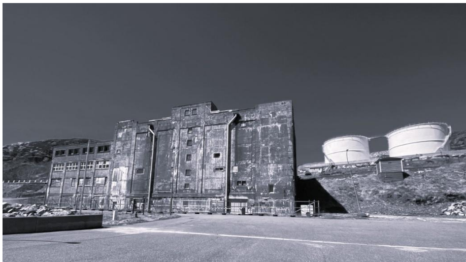
Bâtiment frigorifique à Saint-Pierre (source : photo personnelle)
