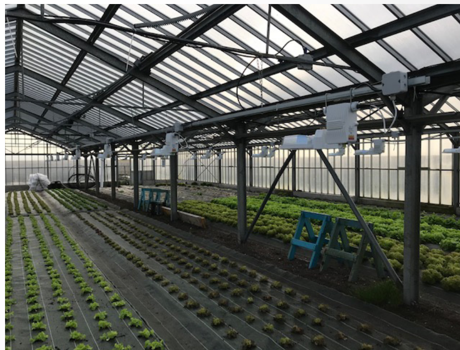
Éclairage au sodium dans les serres à salades de Floradécor.
